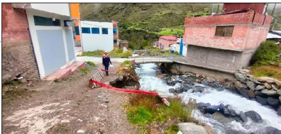
FIGURA N°03: SE APRECIA LA SOCAVACIÓN DE TALUD DE CAMINO Y EXPOSICIÓN AL RIESGO DEL PUENTE PEATONAL MARGEN IZQUIERDA DE LA QUEBRADA AZOQUINE
