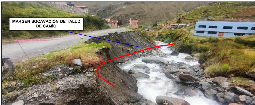
FIGURA N°01: SE APRECIA LA SOCAVACIÓN DE TALUD DE CAMINO MARGEN IZQUIERDA DE LA QUEBRADA AZOQUINE
