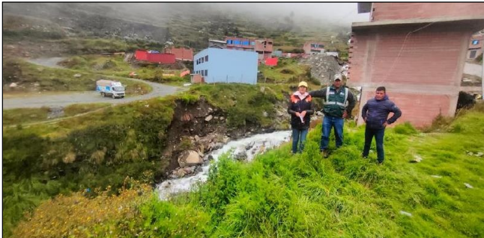
FIGURA N°02: SE APRECIA LA SOCAVACIÓN DE TALUD DE CAMINO Y VIVIENDA FAMILIAR EXPUESTA A LA MARGEN DERECHA DE LA QUEBRADA AZOQUINE
